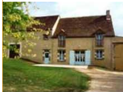
Aménagement d'un gîte labellisé à Saint-Bomer.
